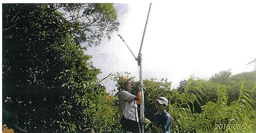
V型ダイポール‥その下に50M Hz帯の八木アンテナを設置。
